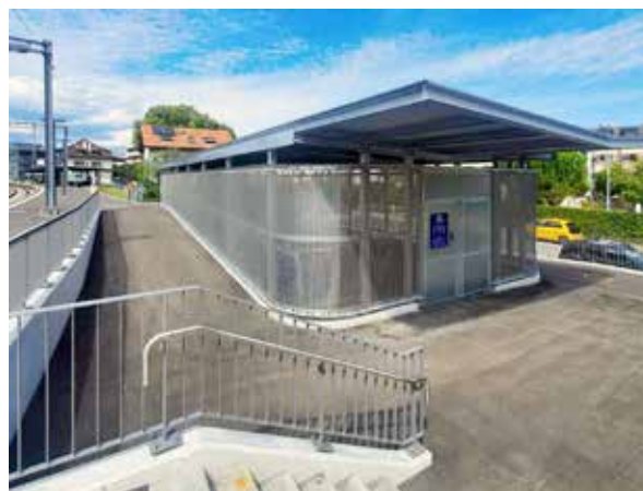
Vélostation de la gare de Versoix
