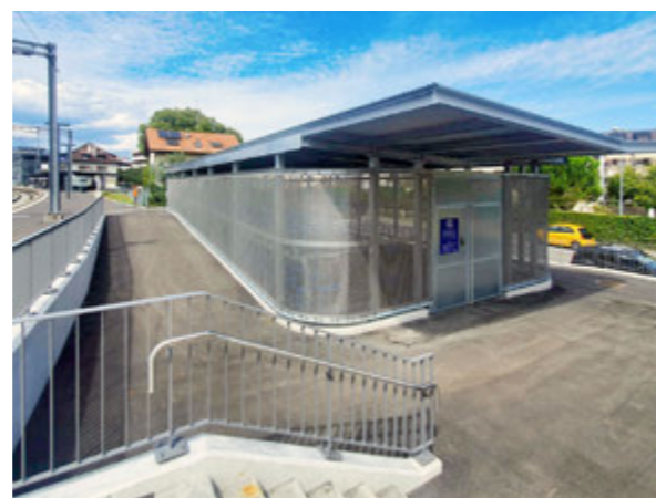
Vélostation de la gare de Versoix
